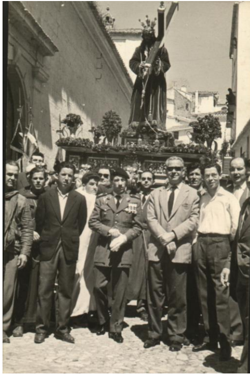
Bajando por calle Atrás. Puerta de la Iglesia.
