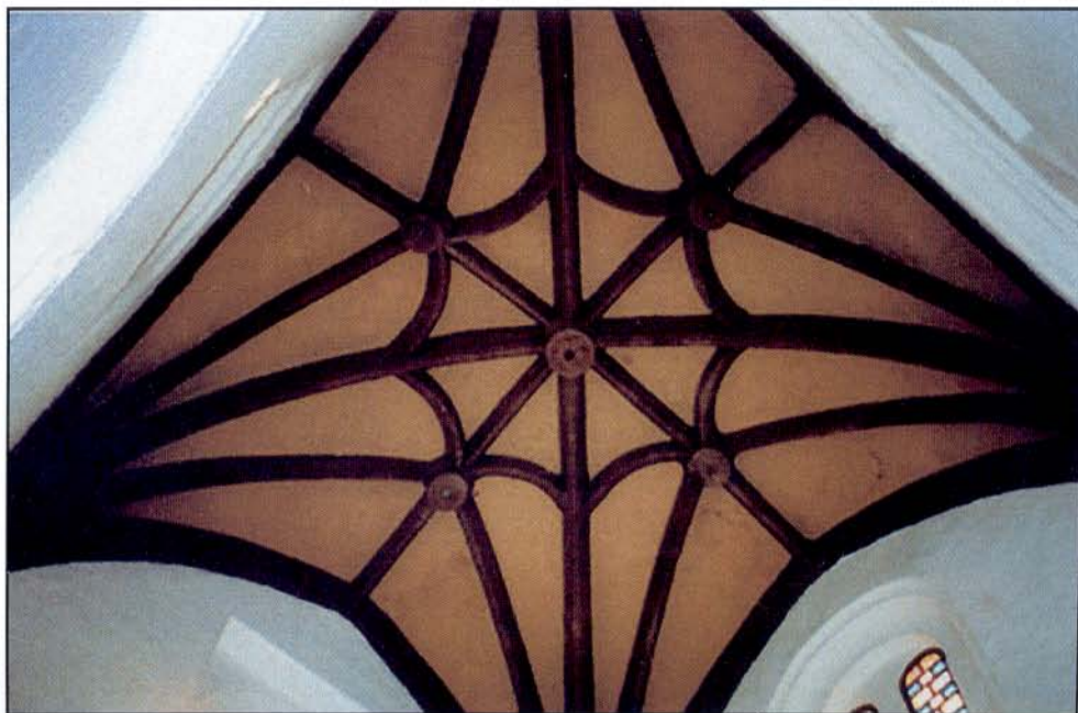
Bóveda estrellada que corona la Capilla de Las Torres.
