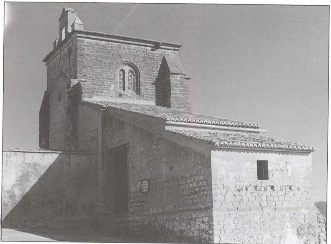
Nuevo aspecto del almacén de "Las Torres" después de las últimas reformas efectuadas.
